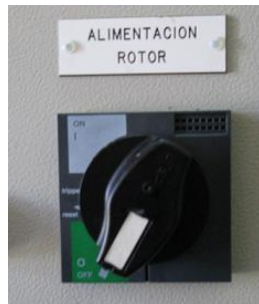
Seccionador Q5 – Alimentación Rotor seccionado o abierto. Ground cabinet, with the Q5 switch outlined in green.
