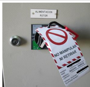
Seccionador Q5 – Alimentación Rotor seccionado o abierto. Ground cabinet, with the Q5 switch outlined in green.
